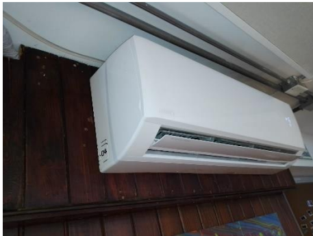
Unidad evaporadora después del mantenimiento
