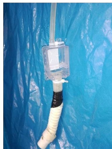
Mini Bomba de condensado durante el mantenimiento
