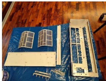
Accesorios de la unidad evaporadora durante el mantenimiento
