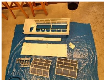
Accesorios unidad Evaporadora durante el mantenimiento
