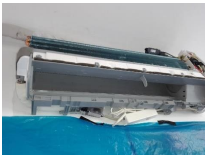
Unidad evaporadora durante el mantenimiento
