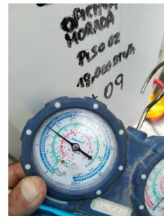
Unidad condensadora durante el mantenimiento
