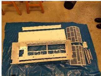
Accesorios unidad evaporadora después del mantenimiento
