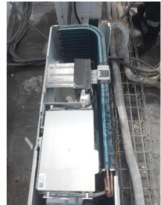
Unidad condensadora durante el mantenimiento
