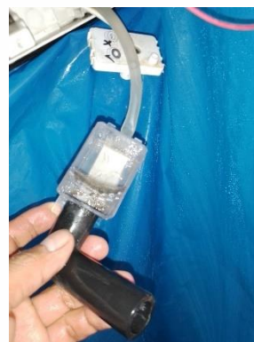
Mini bomba de condensado antes del mantenimiento
