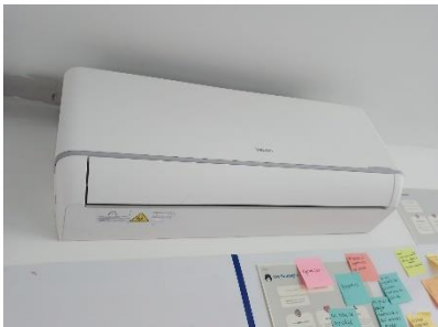
Unidad evaporadora después del mantenimiento
