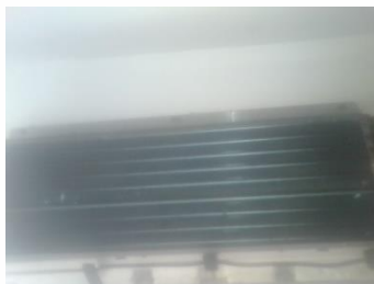
Serpentin de la unidad evaporadora durante el mantenimiento
